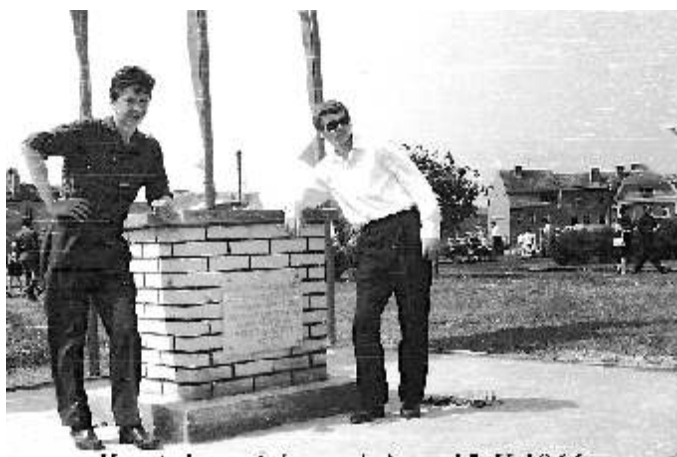
Kamień węgielny położony 15-V-1966 pod budowę pomnika.
