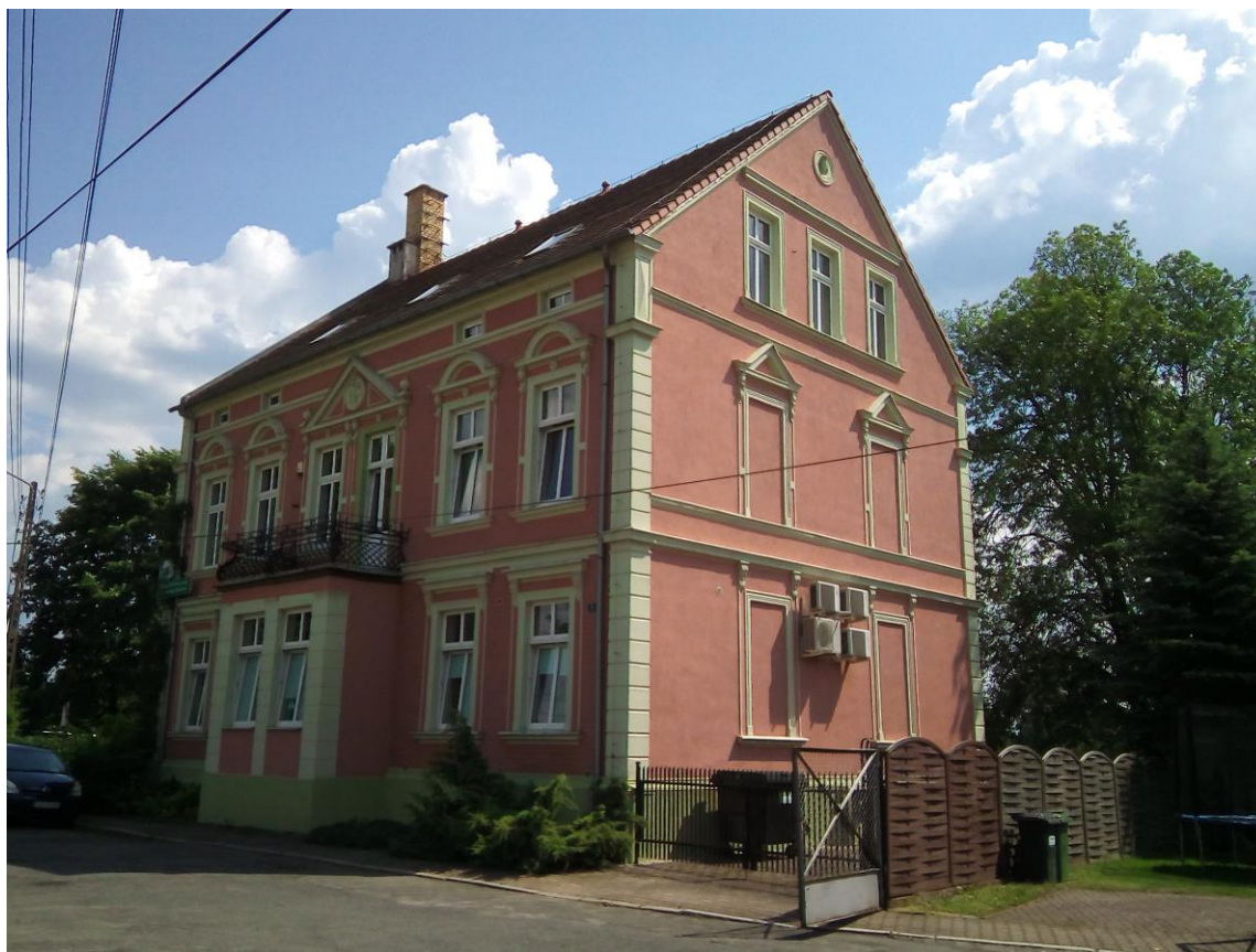
Na budynku przy Placu Prusa nr 4 znajduje się kilka medalionów
