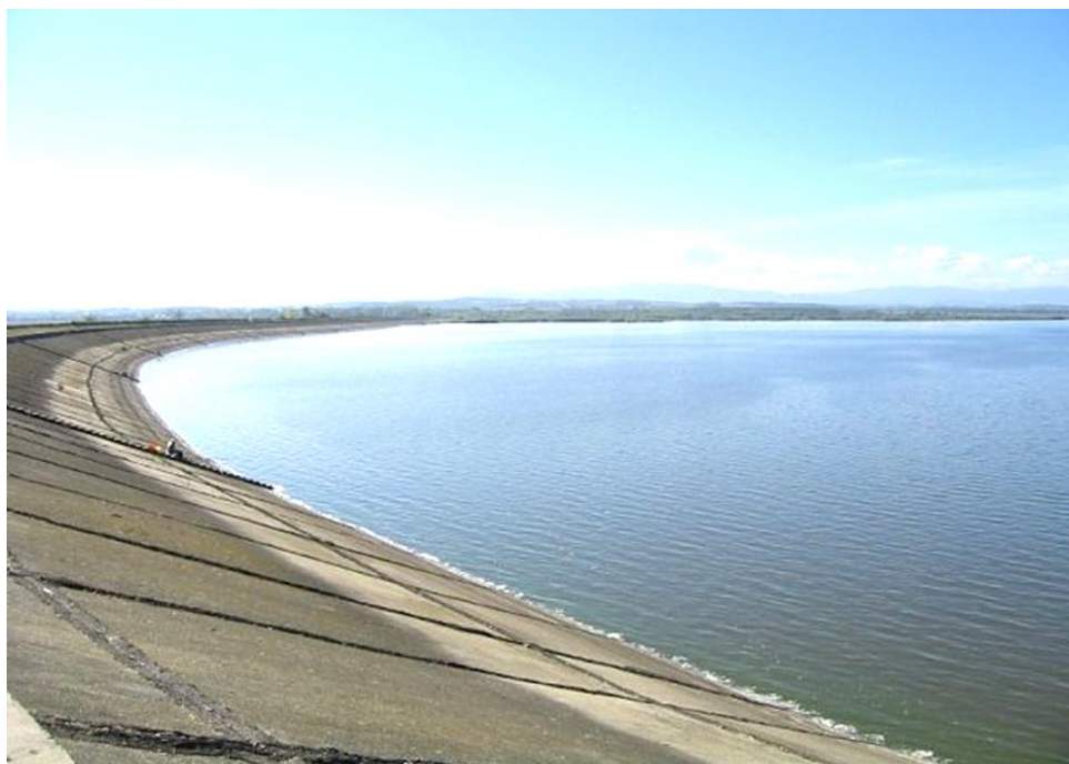
Przykładowy zbiornik retencyjny na rzece
